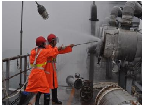
储罐、换热器等污垢清除
